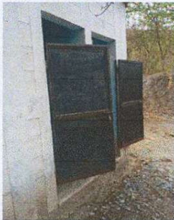
Foto 1: Sustrución de puerta de metal en mal estado, por puertas de metal medida de 1 m * 2.15 m en aula 1, aula 2 y area de baños
