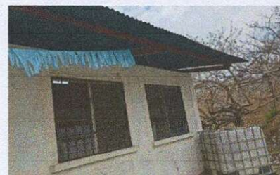
Foto 6: Sustrución de deposito de agua 750lts a un costado de aula 2
