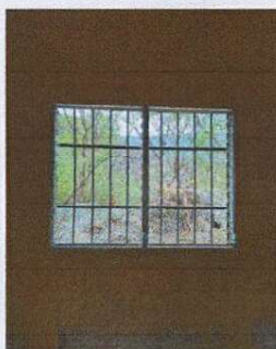
Foto 5: Sustrución de ventanas, por ventanas de pvc en aula 1, aula 2 y en direccion
