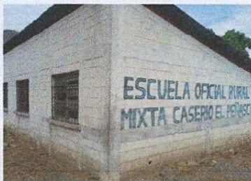
Foto 3: Retoque de pintura en muro interior y exterior de aula 1, aula 2 y en direccion
