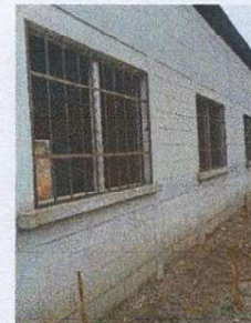
Foto 4: Mantenimiento de balcones lijado y pintura en aula 1, aula 2 y direccion
